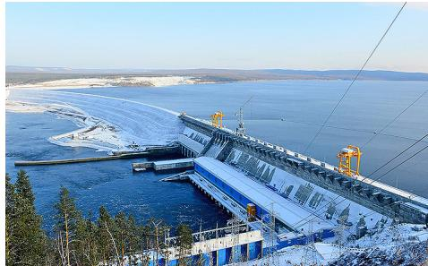
Среднесуточные сбросные расходы установлены в диапазоне 2200-2500 кубометров в секунду, при этом режим может быть скорректирован в зависимости от складывающейся гидрологической обстановки.
